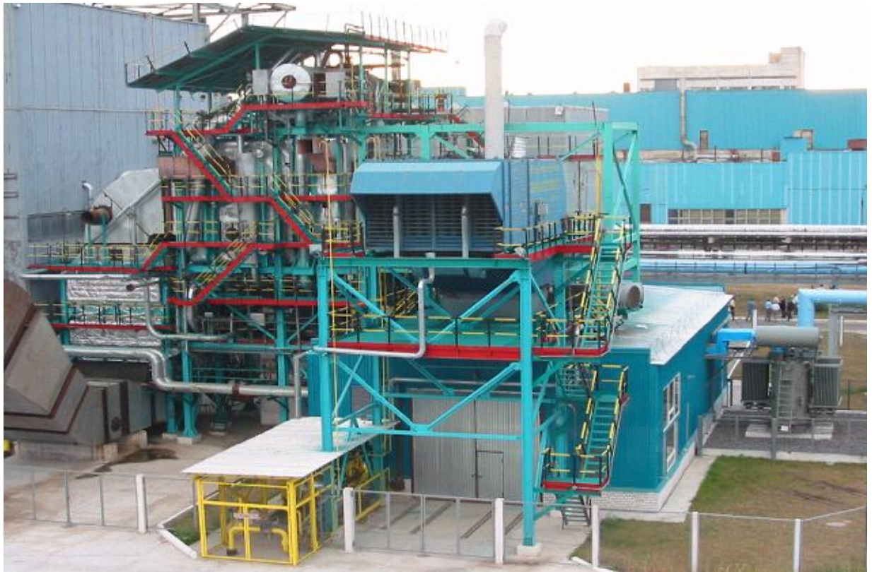
Когенерационный блок 15 МВт + КУП-70 (70 т/ч пара) + 6 МВт (паровая турбина), «Рубежанский картонно-тарный комбинат», г. Рубежное, Украина
