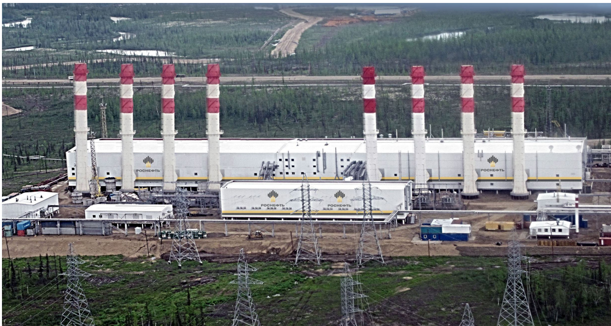
8 КУВ-33 за 8 ГТУ General Electric MS-5001 (26 МВт), ГТЭС 200 МВт, Ванкорское месторождение, Красноярский край, РФ
