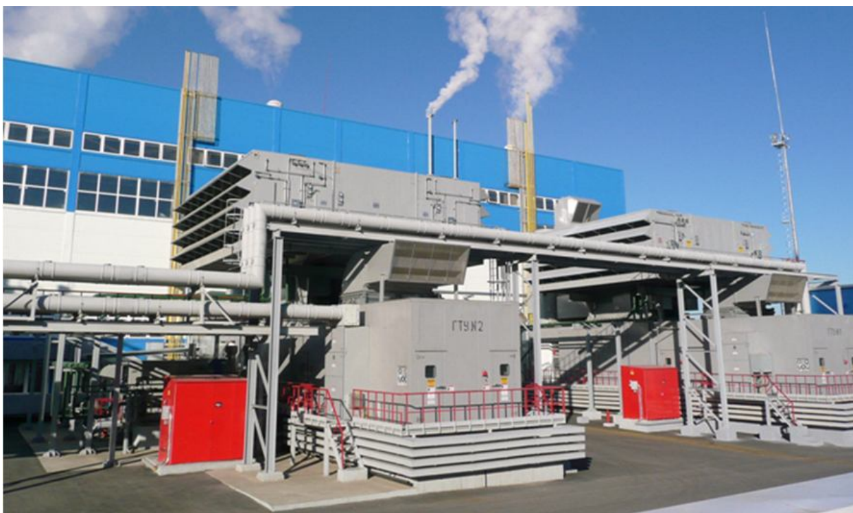
2 КУП-75-3,9-440 (75 т/ч пара) за 2 ГТУ General Electric LM6000 PD Sprint (45 МВт), ПГУ-115 МВт на Воронежской ТЭЦ-2, г. Воронеж, РФ
