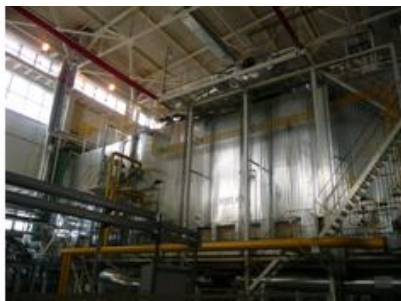
8 КУВ-33 за 8 ГТУ General Electric MS-5001 (26 МВт), ГТЭС 200 МВт, Ванкорское месторождение, Красноярский край, РФ
