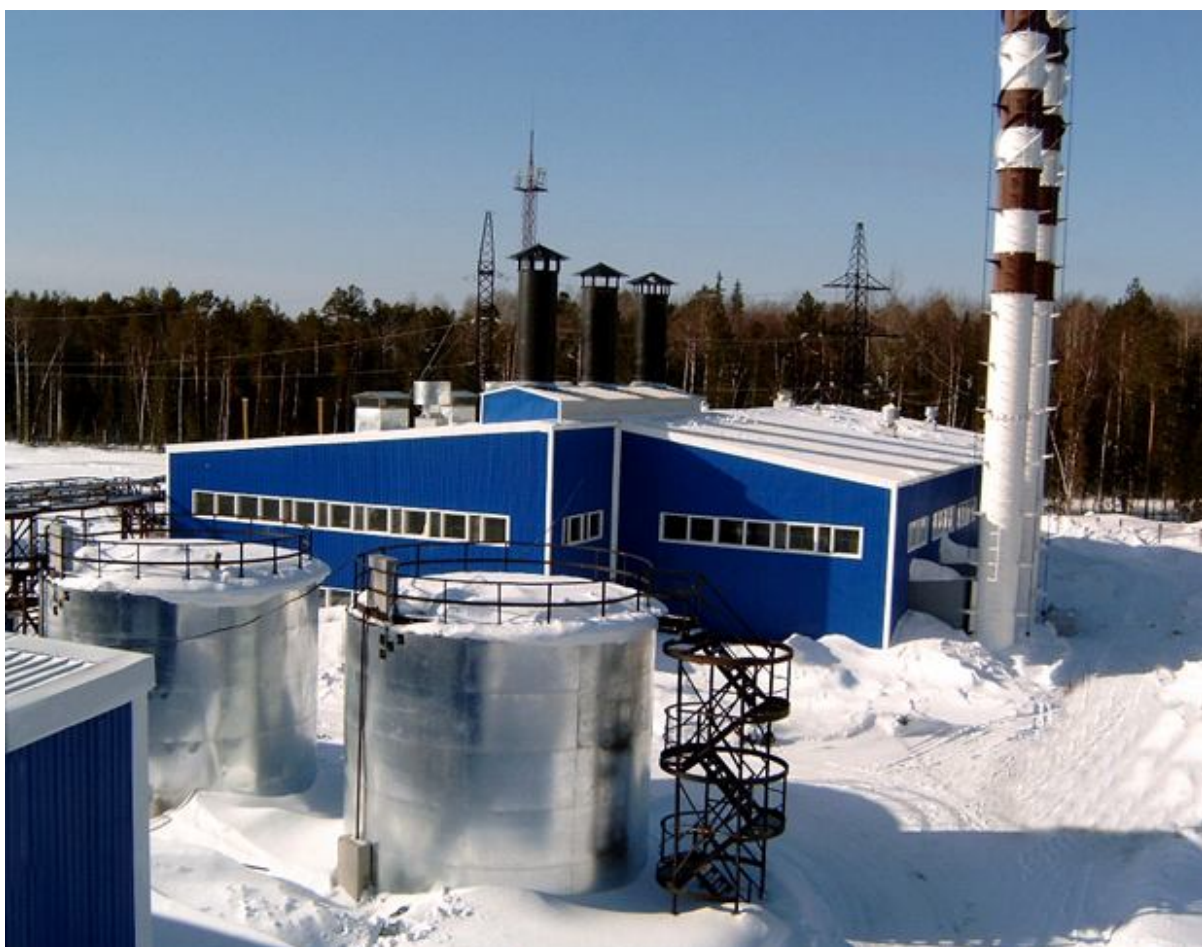
ГТЭС-10 МВт Западно-Полуденного месторождения НГДУ «Стрежевойнефть», РФ
