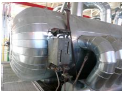
8 КУВ-33 за 8 ГТУ General Electric MS-5001 (26 МВт), ГТЭС 200 МВт, Ванкорское месторождение, Красноярский край, РФ
