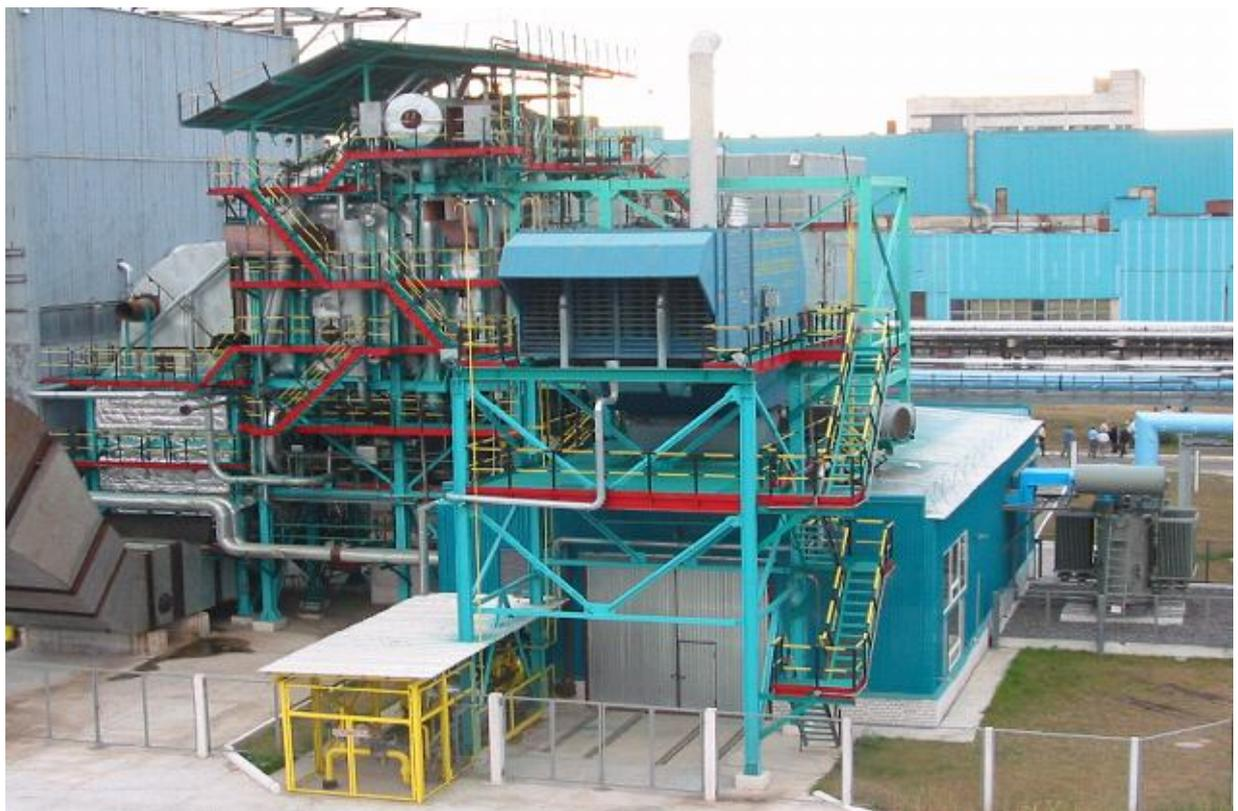
**Когенерационный блок 15 МВт + КУП-70 (70 т/ч пара) + 6 МВт (паровая турбина),
