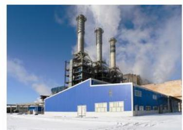
Котлы **КУВ-5,3** и **КУП-25** предназначены для утилизации тепла продуктов сгорания от газотурбинных двигателей мощностью **2,5 МВт** (АИ-20).
